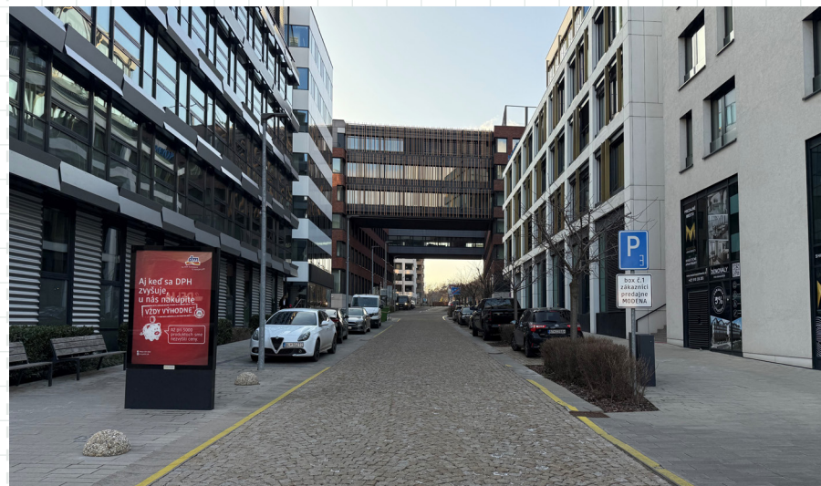
23 Stavebné riešenie ulice v obytnej zóne s vyvýšenou plochou, zmenou povrchu vozovky, parkovacím pruhom, záhonom, stromoradiem, lavičkou a reklamným zariadením typu citylight. Žilžkova, Bratislava
