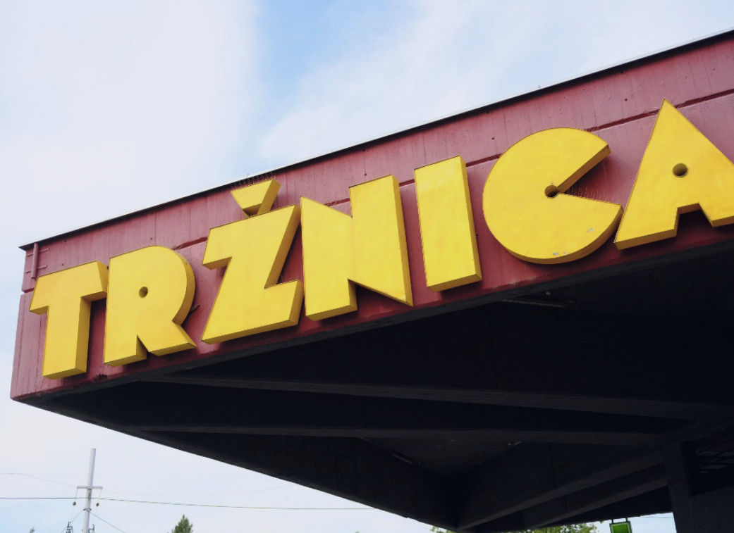
Obr. 07: Exteriér Novej tržnice.
