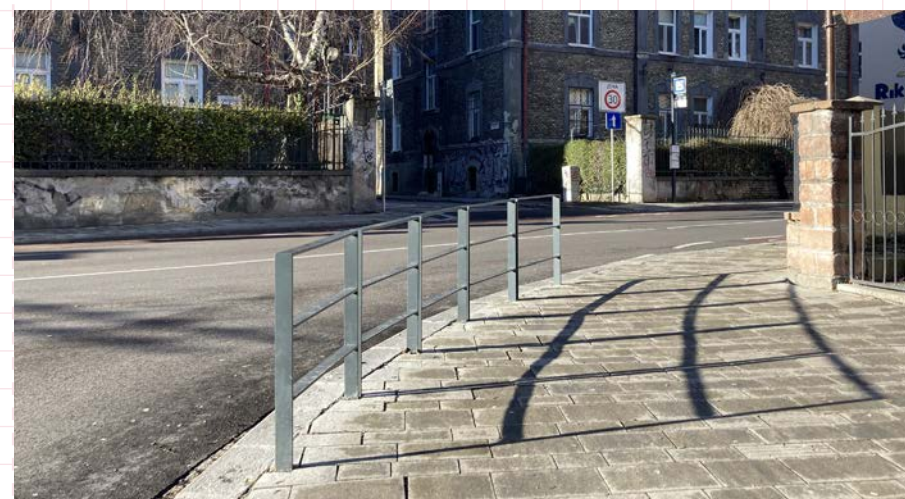
05 Príklad umiestnenia segmentového zábradlia v oblúku (osová dĺžka segmentov 1 m). Bratislava, Karpatská ulica
