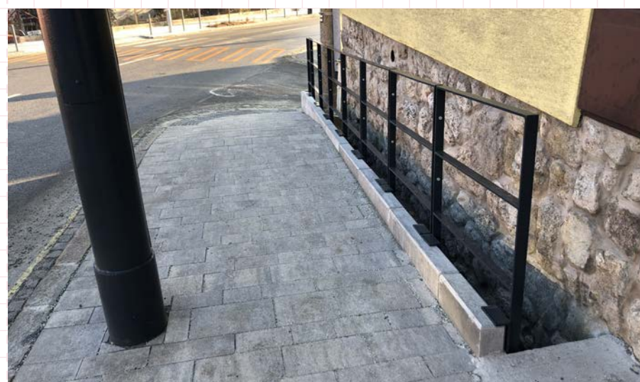
26 Príklad bočného kotvenia segmentového zábradlia. Bratislava, Jeséniova ulica
