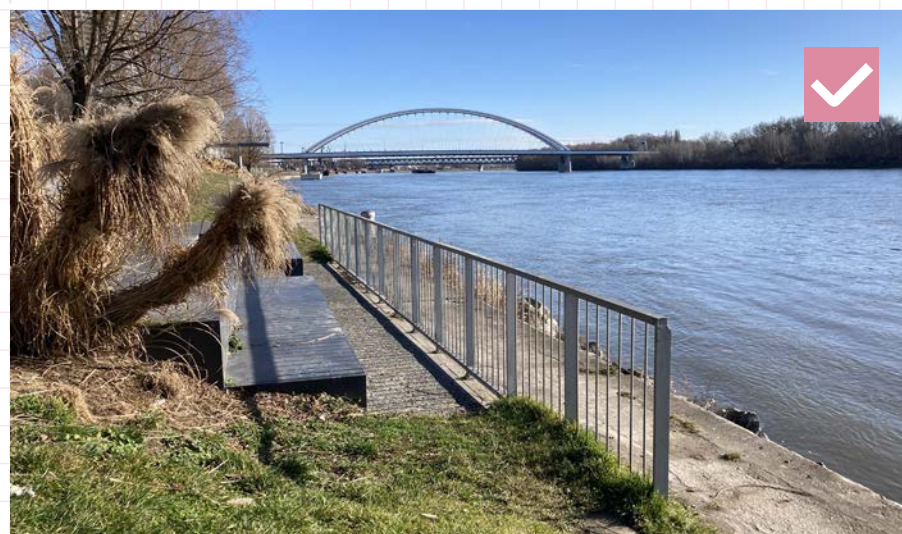
32 Príklad umiestnenia ochranného zábradlia na vyvýšenej hrane vodného toku. Bratislava, Nábřežie Eurovea
