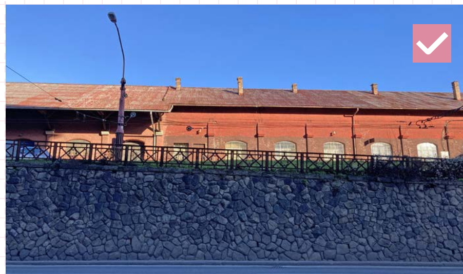
31 Vhodný príklad atypického historického zábradlia umiestneného na opornom múre. Bratislava, Pražská ulica
