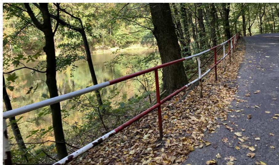
13 Ochranné zábradlie umiestnené na hrane cyklistickej komunikácie v blízkosti vodnej nádrže. Bratislava, Železná studienka
