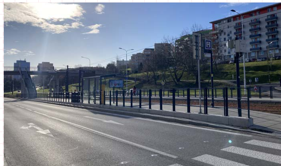
11 Príklad zábradlia umiestneného na zadnej strane nástupného ostrovčeka ukončeného pri najbližšom priechode pre chodcov. Bratislava, Karloveská ulica
