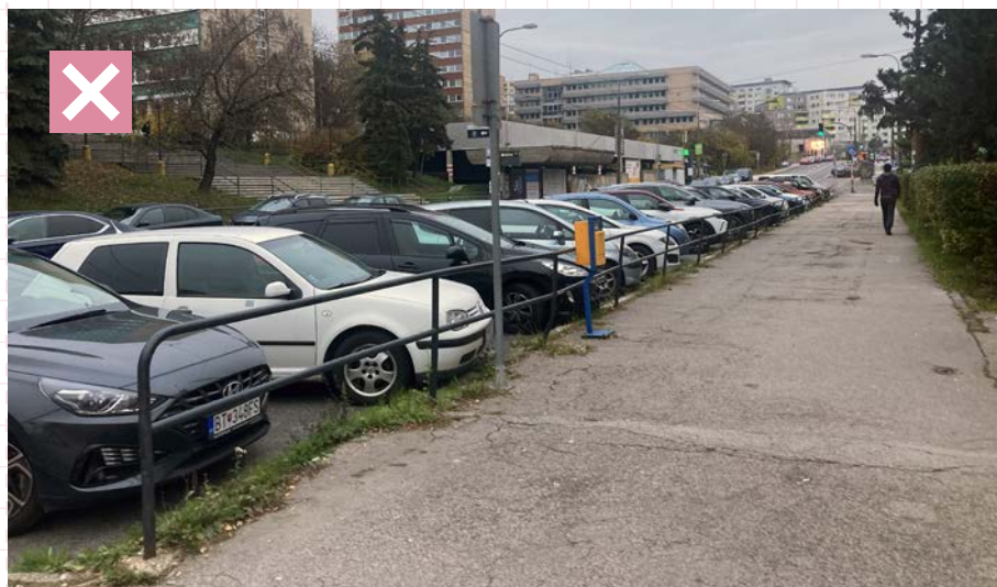
28 Nevhodný príklad umiestnenia zábradlia na rozhraní chodníka a parkovacích miest. Zábradlie tvorí príliš tvrdú bariéru, ľahko sa poškodí. V tomto prípade je vhodné nahradiť ho stĺpkami. Bratislava, Limbová ulica
