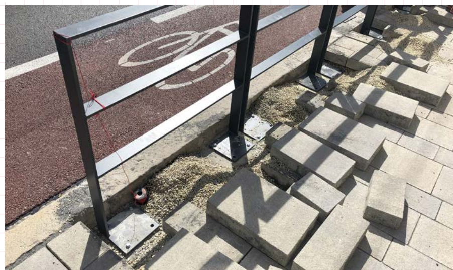
25 Ukážka podpovrchového kotvenia segmentového zábradlia priamo pri hrane obrubníka. Bratislava, Karpatská ulica
