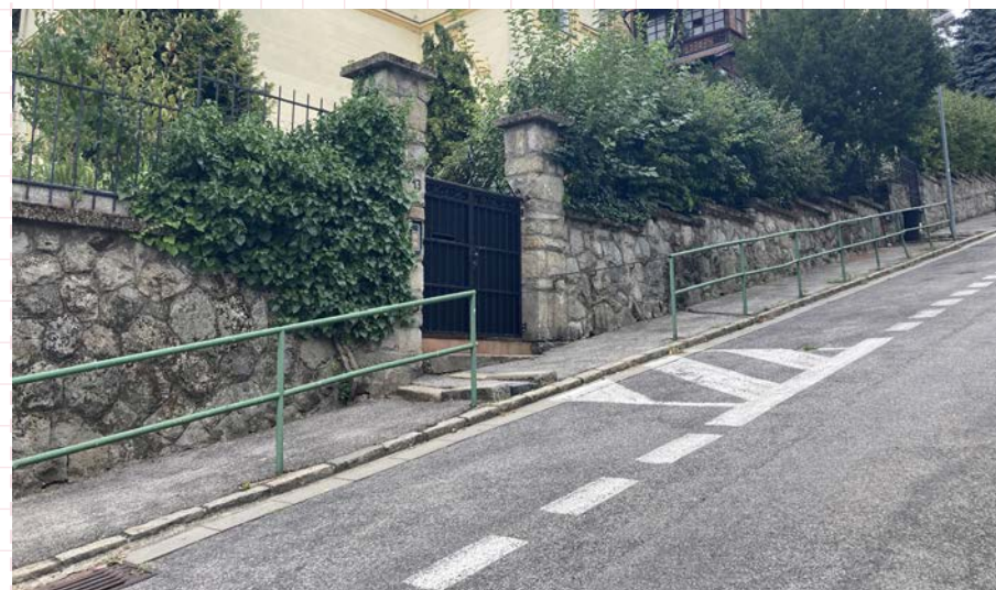
14 Zábradlie umiestnené na rozhraní chodníka a dopravnej komunikácie v ulici so strmým sklonom slúži na podopretie pri chôdzi. Bratislava, Kuzmányho ulica
