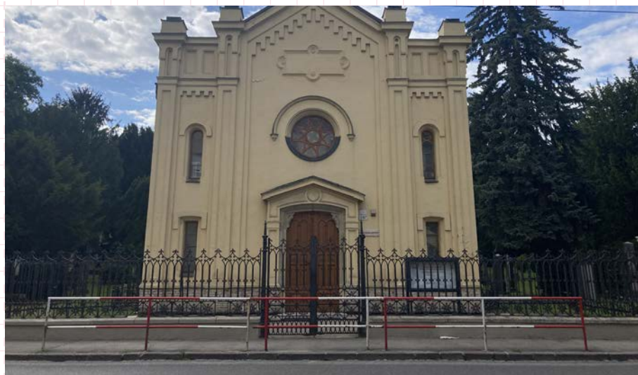
09 Príklad umiestnenia zábradlia pred vstupom do budovy s vysokou koncentráciou ľudí na úzkom chodníku. Bratislava, Palisády
