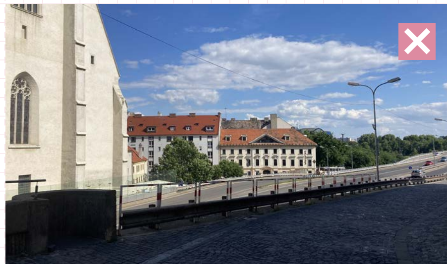
30 Nevhodný príklad ochranného zábradlia na opornom múre. Zábradlie nespĺňa bezpečnostné ani estetické požiadavky do daného priestoru. Bratislava, Židovská ulica
