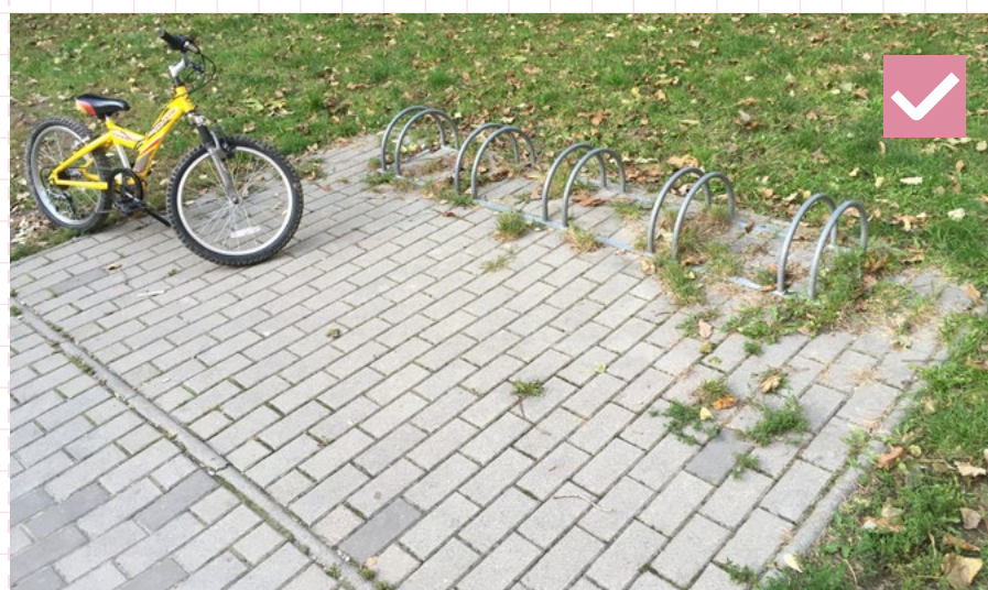
30 Vhodná povrchová úprava priestoru pre parkovanie bicyklov umiestneného v zeleni tvorená dlažbou umožňujúcou vsakovanie dažďovej vody. Nevhodný je dizajn stojana znemožňujúci zamknutie o rám bicykla. Bratislava, detské ihrisko Budovateľská
