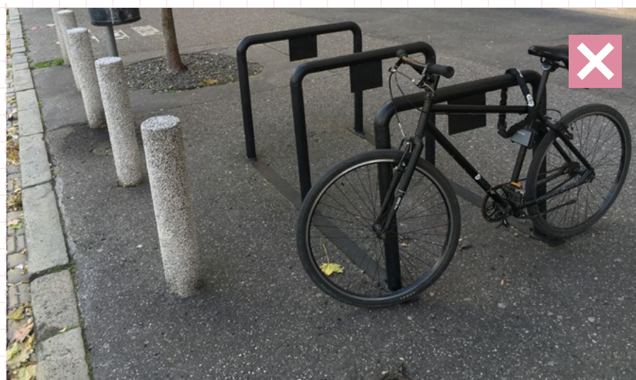
29 Nevhodná duplicita prvkov vo verejnom priestore. Stojan môže nahradiť zahradzovací stĺpik. Z hľadiska dizajnu je menej vhodné kotvenie pomocou povrchového oceleového stužovacieho pásu. Vhodné je materiálové a farebné prevedenie stojana. Bratislava, Námestie SNP
