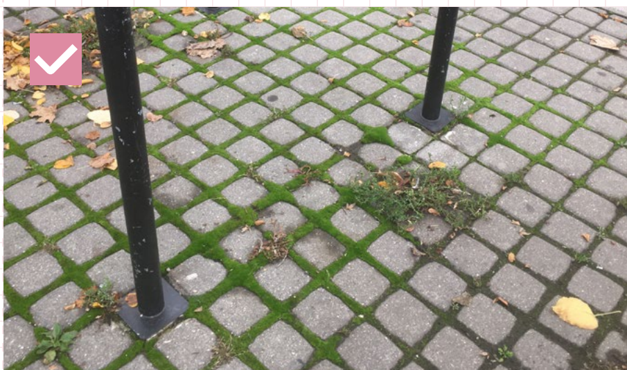
21 Vhodný príklad povrchovo kotveného stojana rešpektujúci rytmus betónovej dlažby
