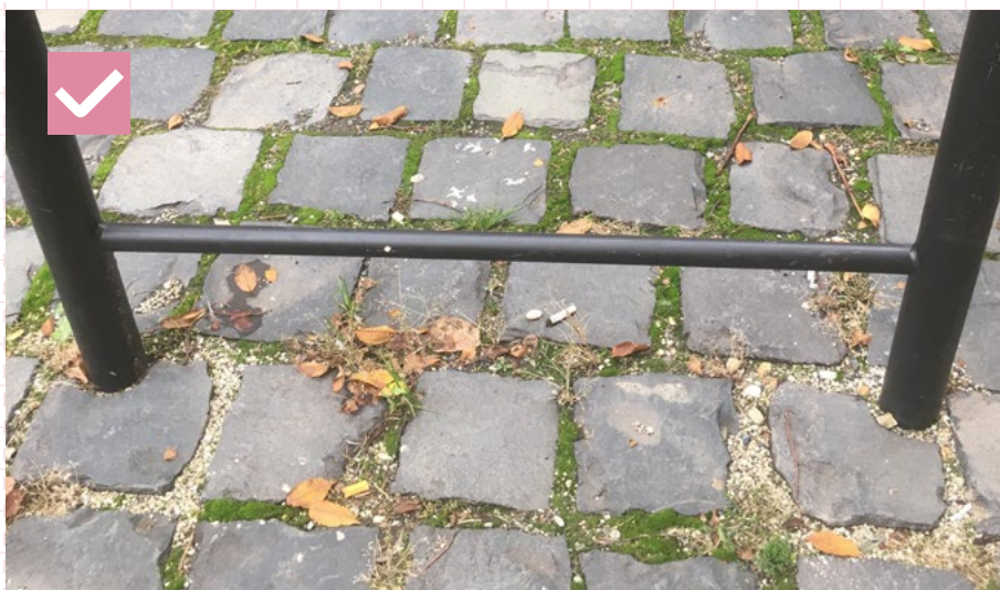
20 Vhodný príklad podpovrchovo kotveného stojana do kamennej dlažby. Využíva špáry na umiestnenie prvku.
