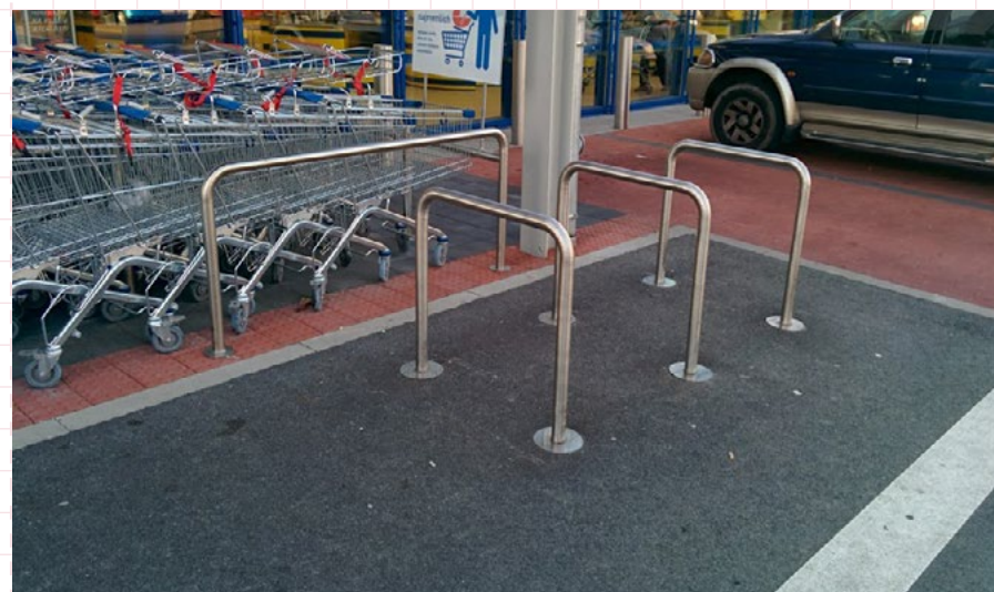
14 Príklad vhodného typu robustnejšieho stojana z pozinkovanej ocele, ktorý vhodne zapadá do kontextu dopravne exponovaného okolia. Bratislava, Pekná cesta
