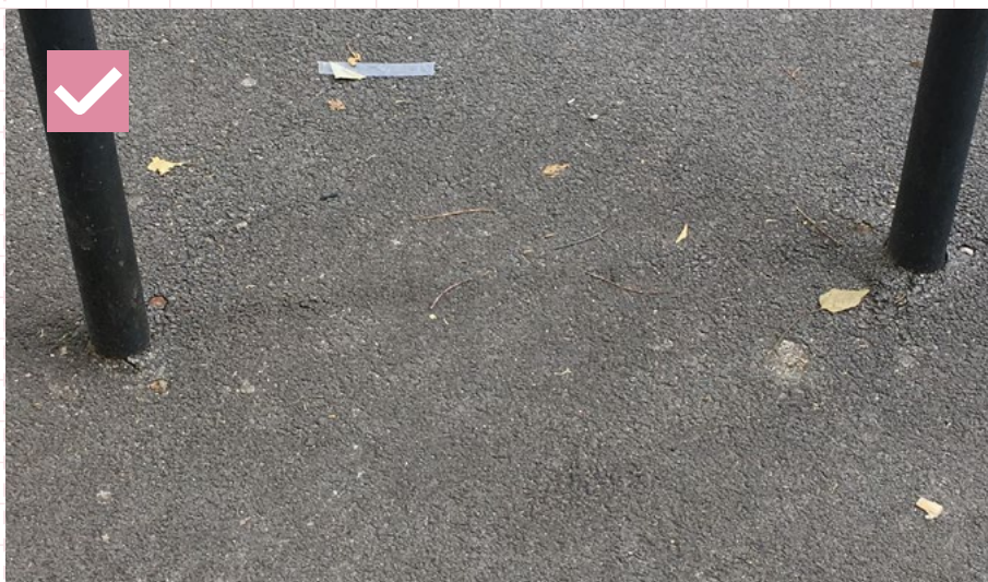
19 Vhodný príklad podpovrchovo kotveného stojana na liatom povrchu.
