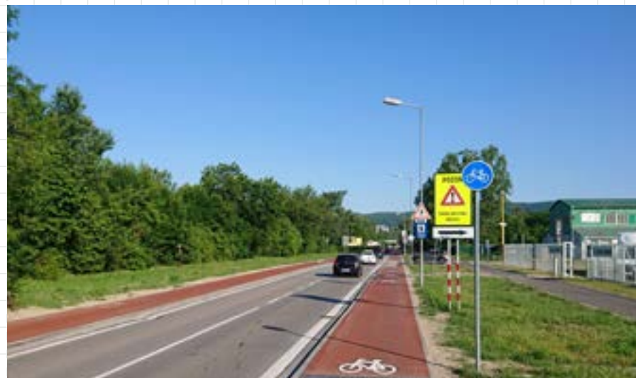
10 Príklad segregovanej cyklistickej komunikácie vedenej v priamom dotyku s vozovkou. Odborárska, Bratislava
