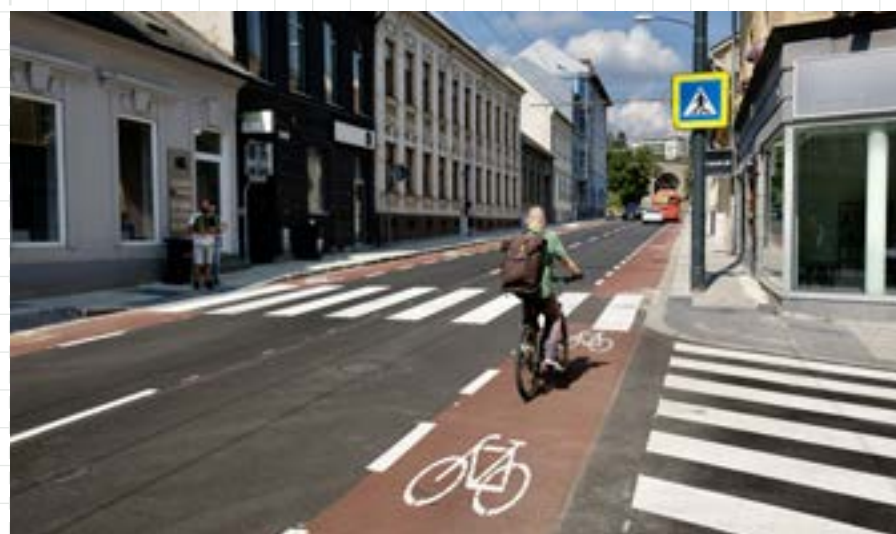
06 Vhodný príklad ochranného pruhu pre cyklistov vyhotoveného z pigmentovaného asfaltu. Bratislava, Karpatská
