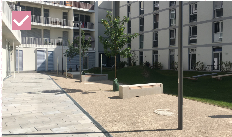
41 Mlatový povrch oddelený od trávnik a oceľovým pásom a od dlažby odvodňovacím žlabom. Rakúsko, Viedeň
