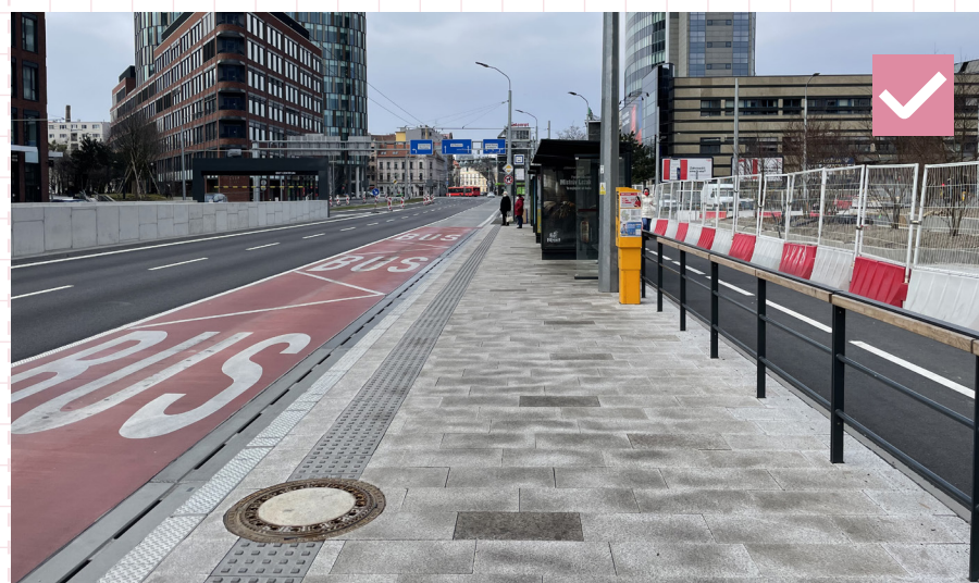
88 Dláždená zastávka električky s hmatateľnými povrchmi. Bratislava, Mlynské nivy
