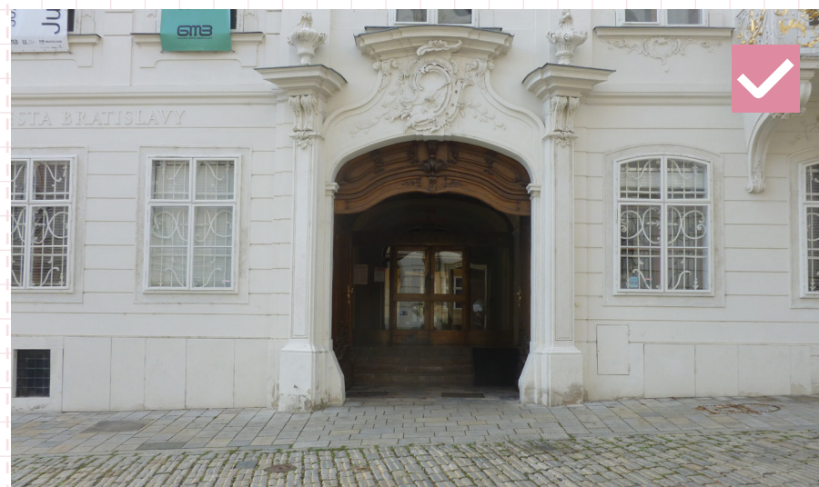
84 Zachovaná kontinuita chodníka, vstup (pravdepodobne historický vjazd) naznačený kolmým kladením rovnej dlažby. Bratislava, Staré mesto
