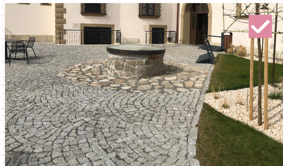
14 Vejáróvito kladená dlažba z kamenných kociek, rastlo ukladané kamene. Svätý Jur
