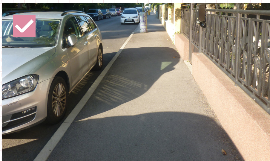
68 Chodník s povrchom z asfaltobetónu s betónovým obrubníkom. Bratislava, Prievoz
