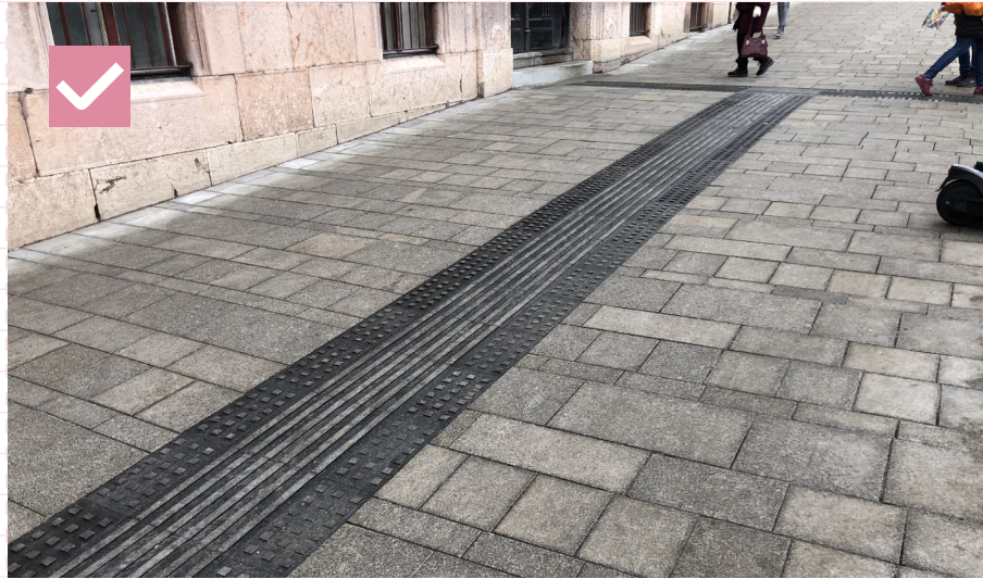
47 Hmatateľný povrch z kamennej dlažby. Bratislava, Námestie SNP
