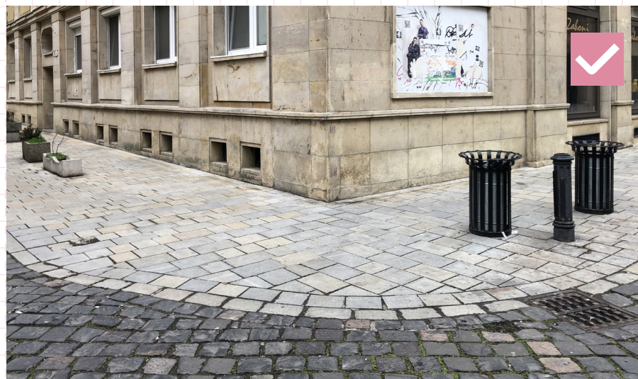
37 Plynulý prechod dlažby v nároží. Bratislava, Laurinská
