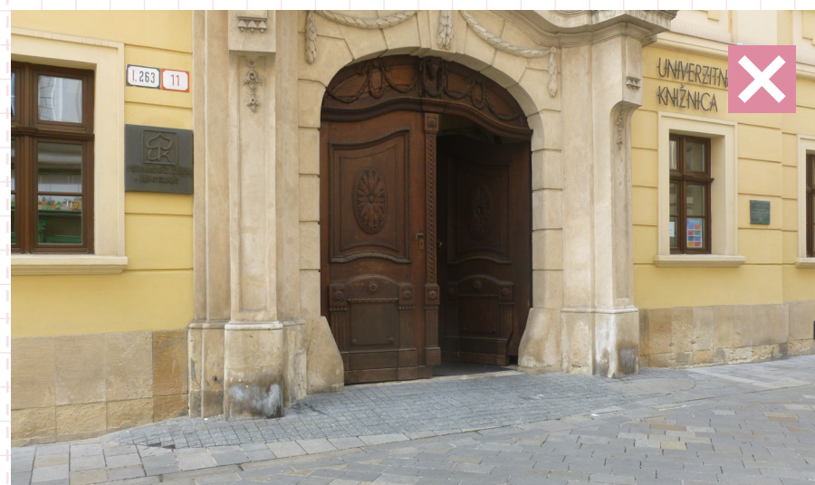
85 Narušená kontinuita chodníka, vchod do budovy zvýraznený odlišným materiálom a odlišným farebnosťou dlažobnej kocky. Bratislava, Staré mesto
