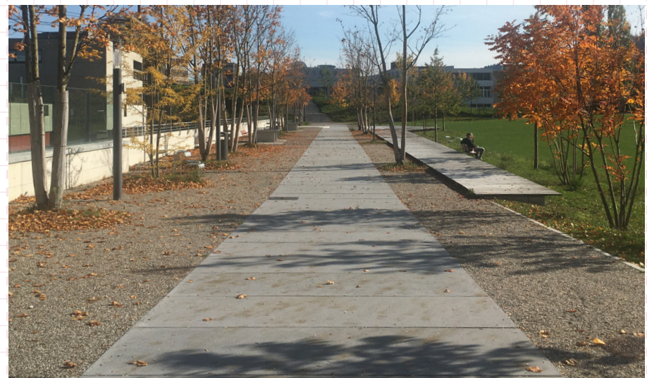
12 Betónový chodník s pravidelným škárovaním. Švajčiarsko, Bazilej
