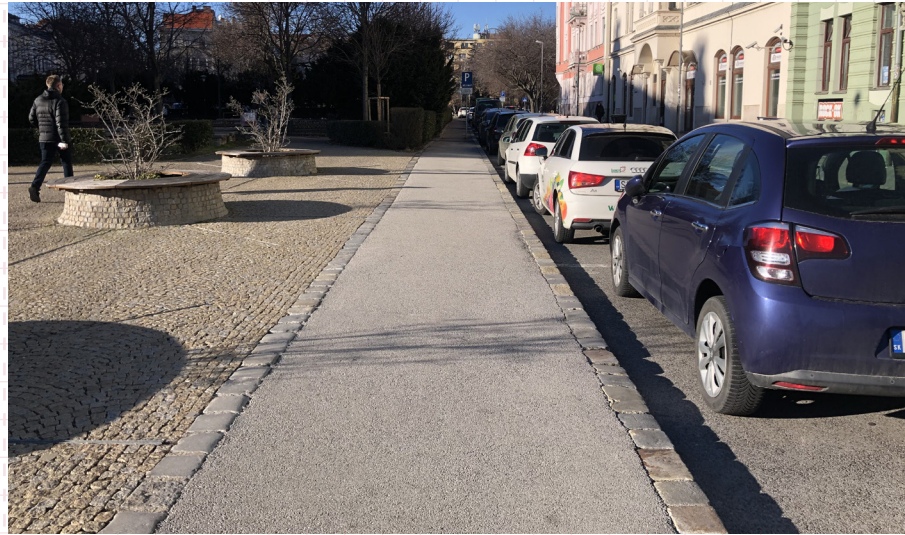
07 Asfaltový chodník s kamenným krajníkom a obrubníkom. Bratislava, Šafárikovo námestie
