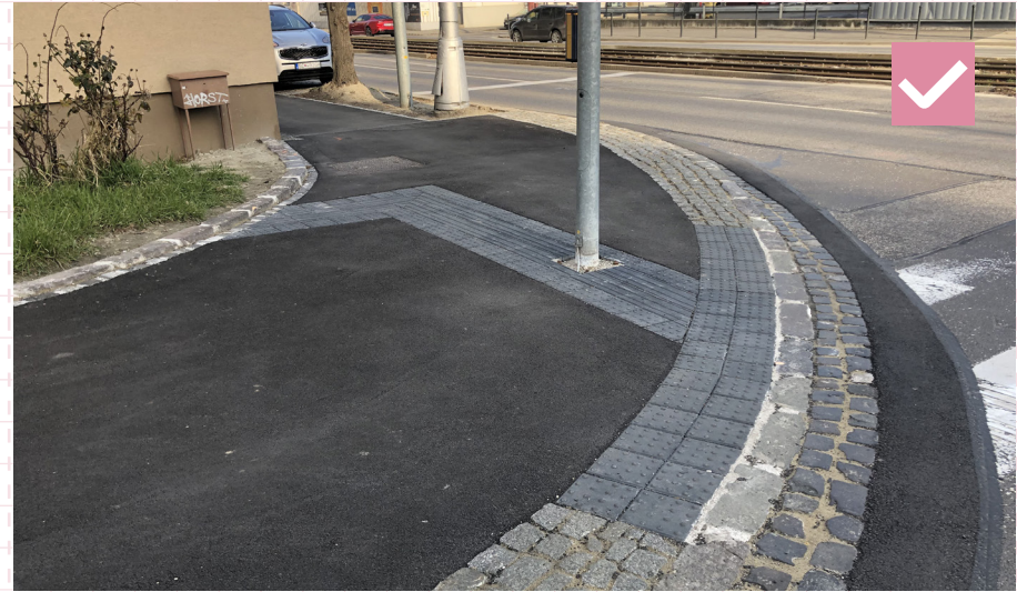
50 Vhodné vyhotovenie hmatateľného povrchu v inom farebnom odtieni rovnakej farby. Bratislava, Račianska
