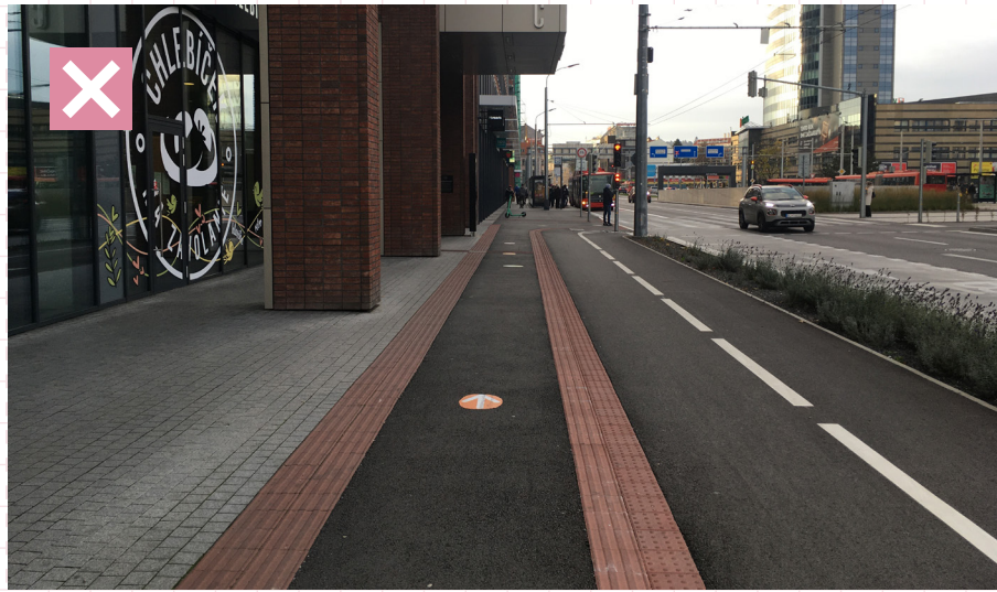
43 Nevhodné použitie červených hmatateľných povrchov, ktoré chodník opticky zužujú. Bratislava, Mlynské nivy
