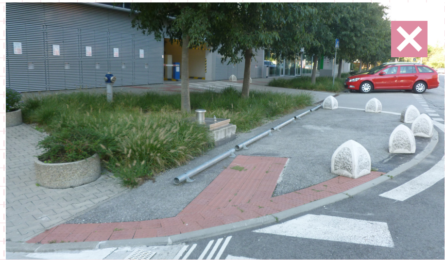
52 Nevhodné vyhotovenie hmatateľného povrchu červenou farbou, signálny pás navádza na chodník s fyzickými prekážkami a bez pokračovania, je dôležité nasmerovanie na smer, ktorý je pre nevidiacich žiadúci. Bratislava, Jarabínková
