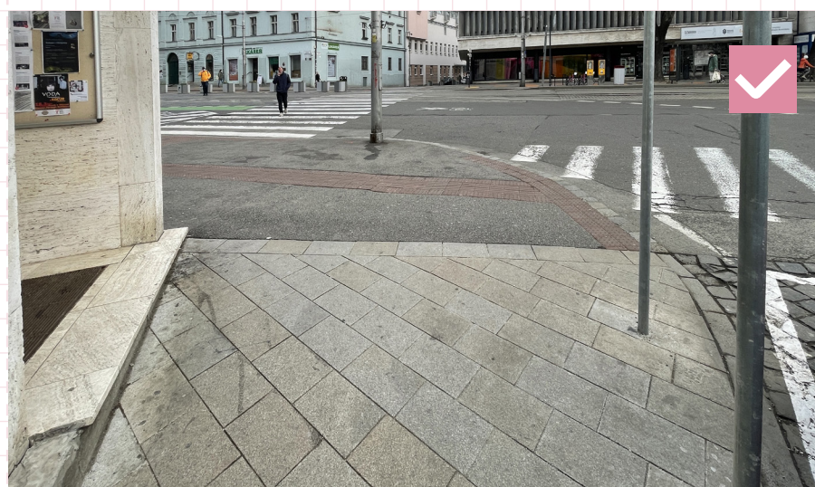
39 Dláždený chodník oddelený od asfaltového radom dlažbových plátň uložených rovnobežne s rozhraním. Bratislava, Námestie SNP
