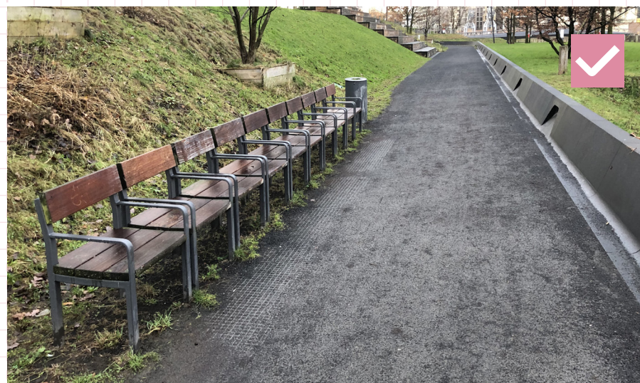
57 Mlatový povrch spevnený roštom v priestore na nohy pred lavičkou. Nemecko, Hamburg
