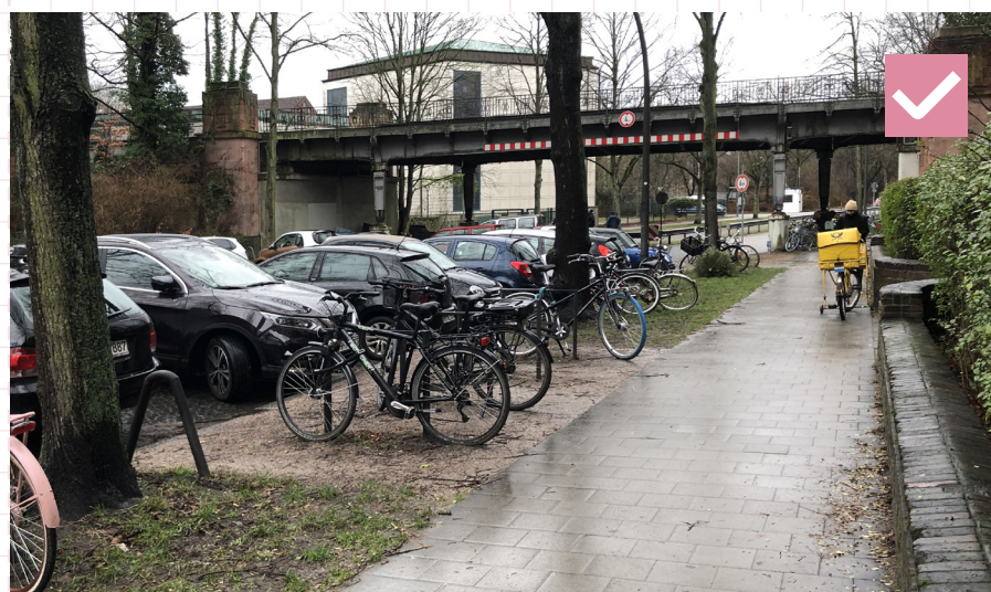
26 Chodník s mlatovým povrchom medzi stromovými jamami. Nemecko, Hamburg
