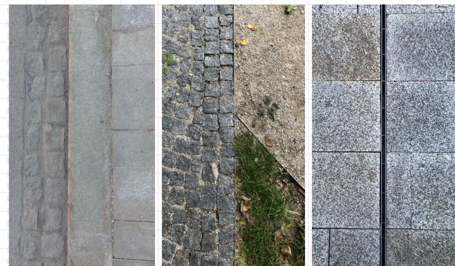
Zľava: kamenný obrubník oceľový obrubník štrbinový žlab.
