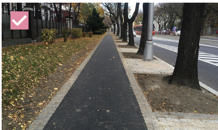
74 Chodník s povrchom z asfaltobetónu s rozhraniami z kamennej dlažobnej kocky. Bratislava, Prievoz
