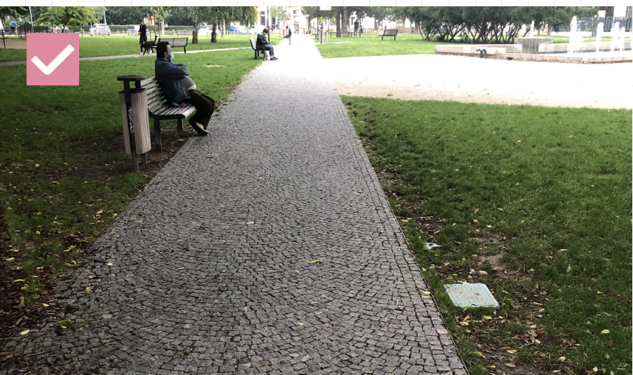
79 Dláždený chodník s rozhraním z ocelevej pásoviny. Bratislava, Landererov park
