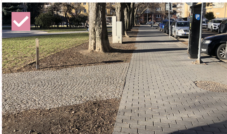
36 Šikmý styk dláždených povrchov s rozhraním z ocelej pásoviny. Bratislava, Landererov park
