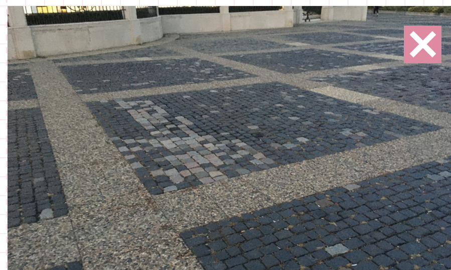
58 Nevhodne vyhotovená oprava povrchu použitím kamenných dlažbových kociek odlišnej farby. Bratislava, Staré mesto
