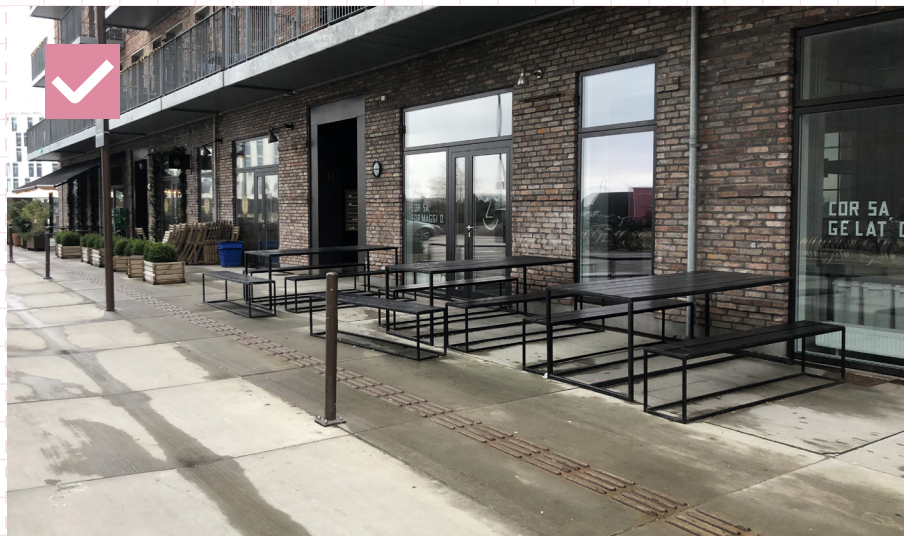
49 Hmatateľné prvky z cortenu, umelá vodiaca línia paralelná s fasádou naviguje nevidiaceho po bezpečnej trase a pri fasáde je ponechaný priestor pre terasové sedenie, ktoré netvorí bariéru. Dánsko, Kodaň
