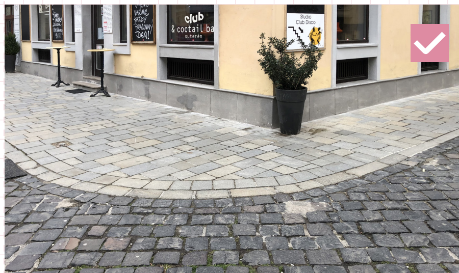
38 Úsek dlažby ukončený zároveň s fasádou zvýrazňujúc hierarchiu ťahov/nadradenosť chodníka. Bratislava, Laurinská
