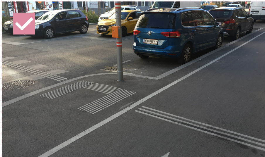
48 Hmatateľný povrch z indikátorov zo studeného plastu. Rakúsko, Viedeň
