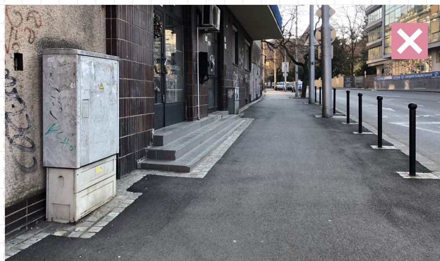
23 Pás lemovania zbytočne zasahuje do priestoru, je zhotovený so zbytočnými zalomami, okolo schodu nie je potrebný. Bratislava, Palisády
