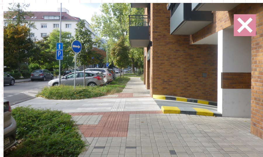
67 Narušená kontinuita chodníka znížením jeho úrovne, nadradením prejazdu pre vozidlá do obytnej budovy a použitím hmatateľných povrchov červenej farby. Bratislava, Steinov dvor
