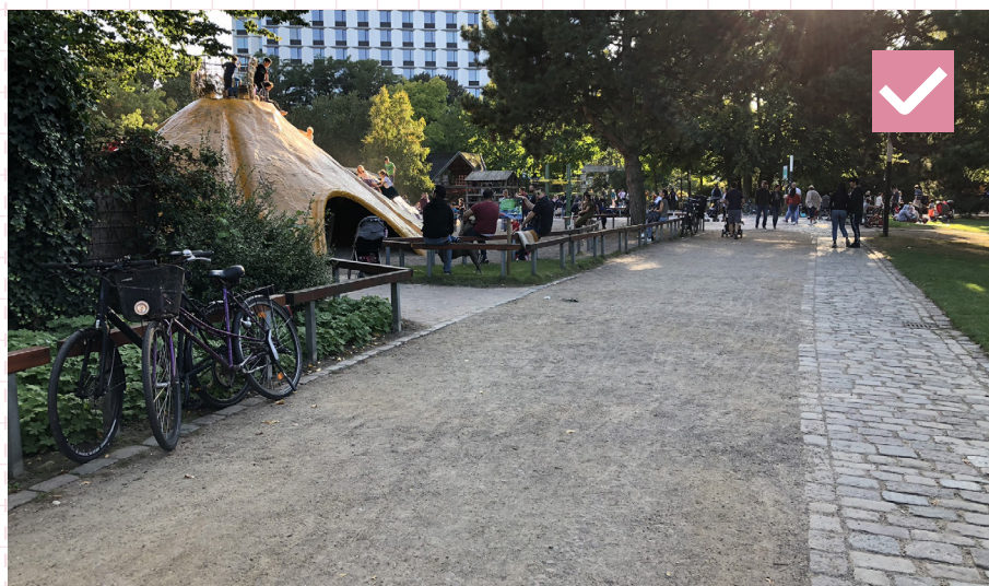
81 Kombinácia dláždeného a mlatového povrchu s rozhraniami z kameňa po oboch stranách chodníka. Nemecko, Hamburg
