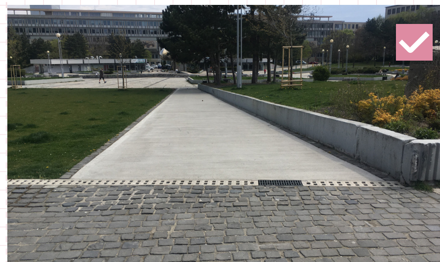
53 Odvodňovací žlab farebne ladiaci s okolím umiestnený na rozhraní odlišných materiálov Bratislava, Námestie slobody
