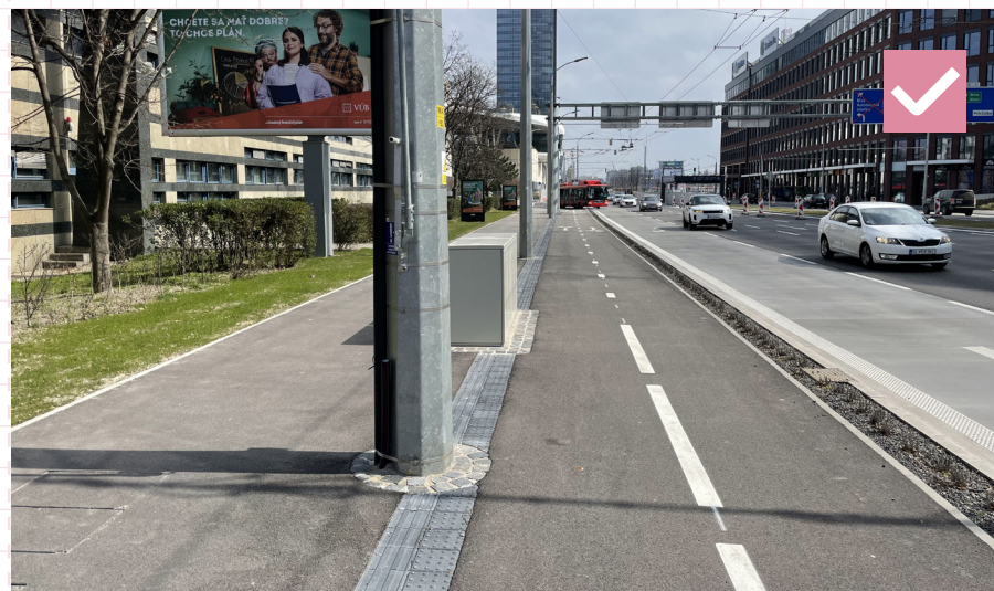
33 Pás lemovania okolo prvkov technickej infraštruktúry. Bratislava, Mlynské nivy
