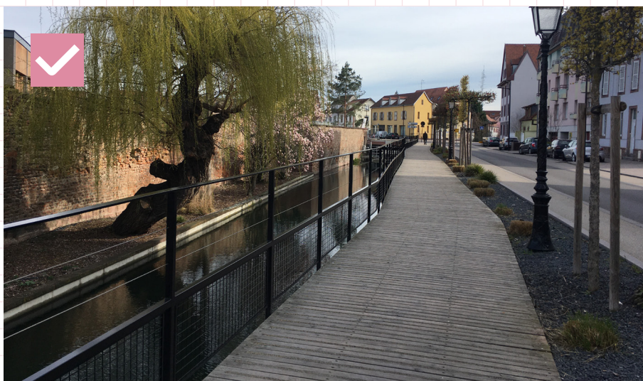
78 Chodník z drevených lát so špeciálnym detailom zabezpečujúcim protišmykovosť. Francúzsko, Colmar
