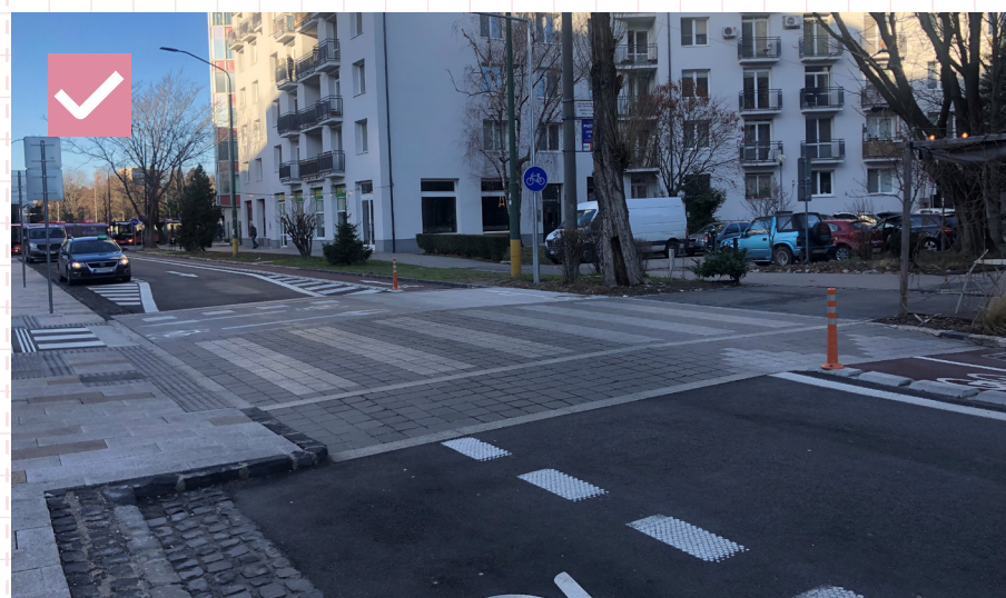
64 Priechod pre chodcov, ktorý je súčasťou spomaľovacieho prahu je možné vyhotoviť z farebne kontrastných dlažbových prvkov. Bratislava, Páříčkova ulica
