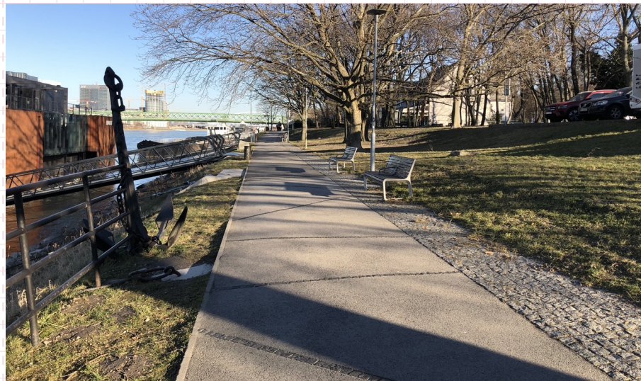
08 Asfaltový povrch so segmentami predelenými malou kamennou dlažobnou kockou. Bratislava, Promenáda pri Dunaji
