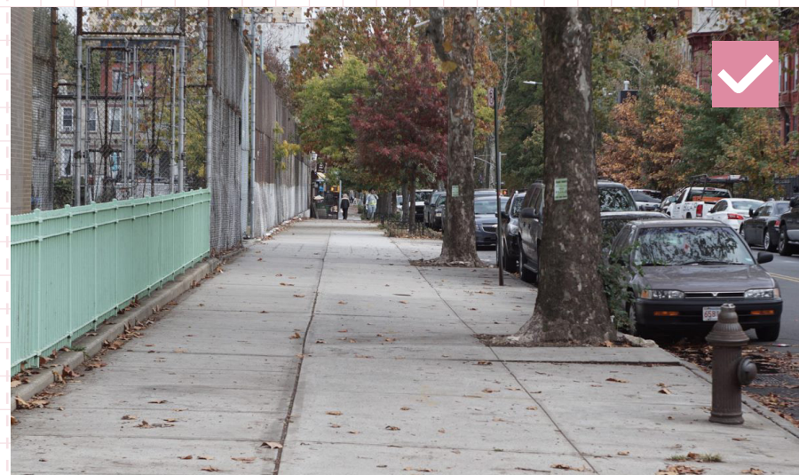
72 Betónový chodník s pravidelným škárovaním. Spojené štáty, New York
