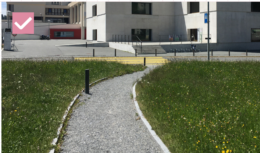
77 Chodník z vibrovaného štrku s kamenným obrubníkom. Svajčiarsko, Zerez
