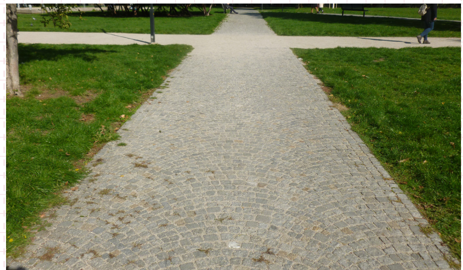
06 Povrch z kamennej dlažobnej kocky s vejárovitým kladením s oceľovým obrubníkom. Bratislava, Landererov park
