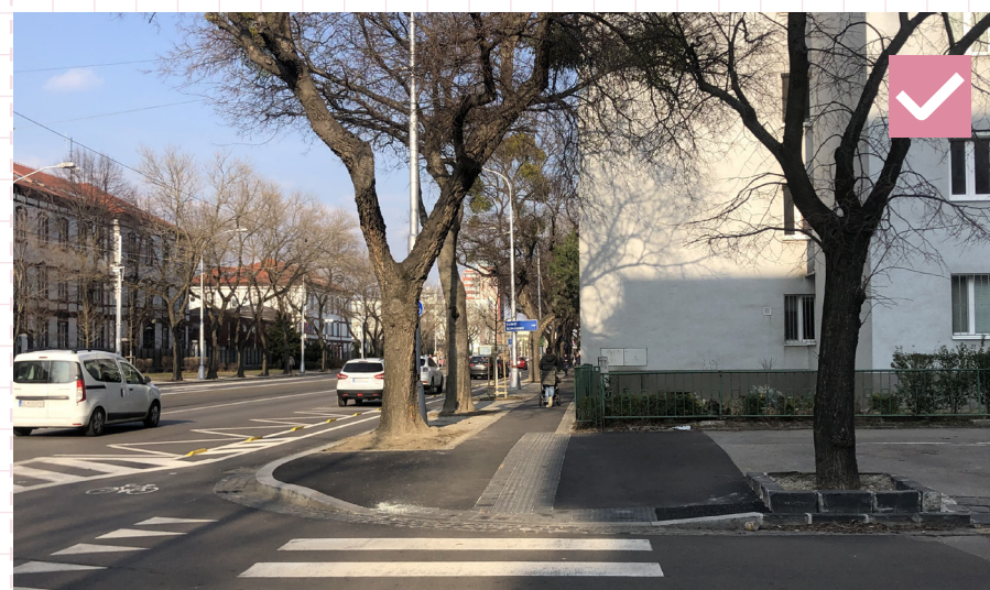
20 Ucelený úsek zahŕňajúci priechod pre chodcov a rešpektujúci polohu výsadbovej jamy. Bratislava, Vajnorská - Prikopova
