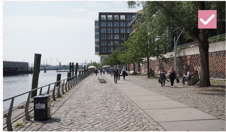
51 Bezbariérový hladký povrch vytvorený z betónových plátň. Nemecko, Hamburg
