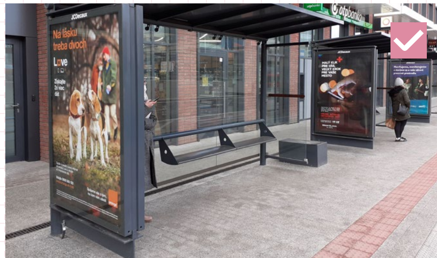
35 Prestrešenie ukotvené na inej konštrukcii (v tomto prípade protiľuková stena na moste) je vhodný príklad riešenia prekrytia nástupišťa na veľmi úzkom chodníku. Dôležité je, že prestršenie dizajnovovo tvorí jeden celok s konštrukciou, na ktorú je ukotvené. Bratislava, zastávka Most Apollo
