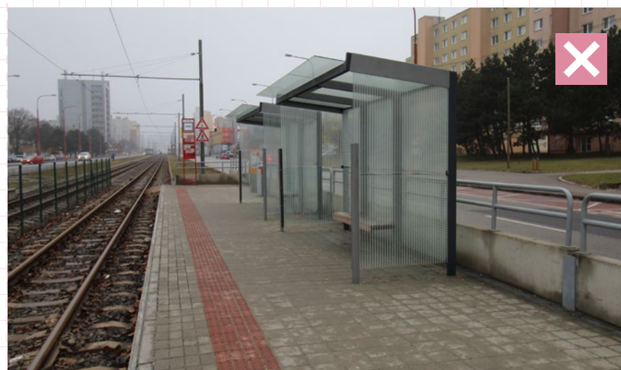
16 Nevhodný príklad sieťotlačce, ktorá je príliš nahusto, čím sa stráca žiadaný efekt transparentnosti prístrešku. zastávka Pri križi, Bratislava
