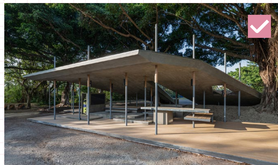
25 Originálne riešenie prekrytia priestoru pre čakajúcich v prírodnom prostredí v blízkosti kampusu vhodne zapadá do prostredia. Prestrešenie poskytuje dostatočný komfort čakajúcim, má integrovaných viac možností posedenia, automat na lístky, ale tiež informačnú vitrínu. Použitie materiály: drevená podlaha a posedenie, kovová konštrukcia a betónová konštrukcia vegetačnej strechy. Pochôdzna strecha pokrytá trávou vytvára ďalšie možnosti nielen na čakanie, ale aj na posedenie a relax. Taiwan, Hsínchu
