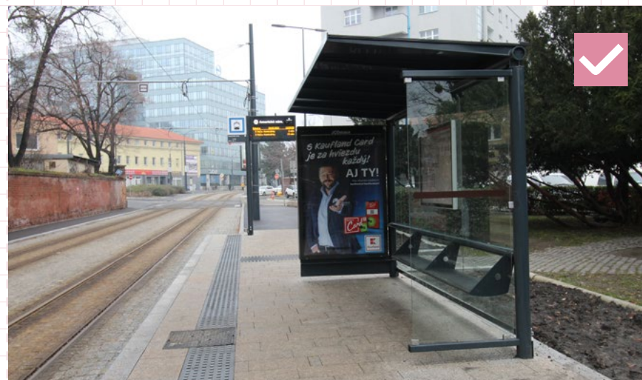
15 Príklad vhodného kotvenia bočnej steny do nosného stĺpu prístrešku, ktorý nepotrebuje dodatočné kotvenie do povrchu nástupišťa. zastávka Americké námestie, Bratislava
