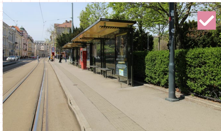
36 Príklad umiestnenia prístrešku na chodníku, ktorý hraničí s plochou zelene, v tomto prípade tvorenou kríkmi. Dôležité je, že medzi prístreškom a kríkmi je zachovaný min. odstup 0,5 m kvôli údržbe zelene a tiež prístrešku. Bratislava, zastávka Safárikovo námestie
