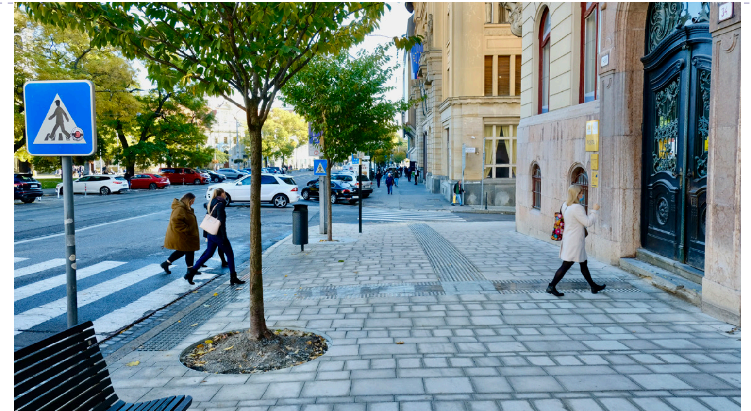
Opravený chodník na Námestí SNP
