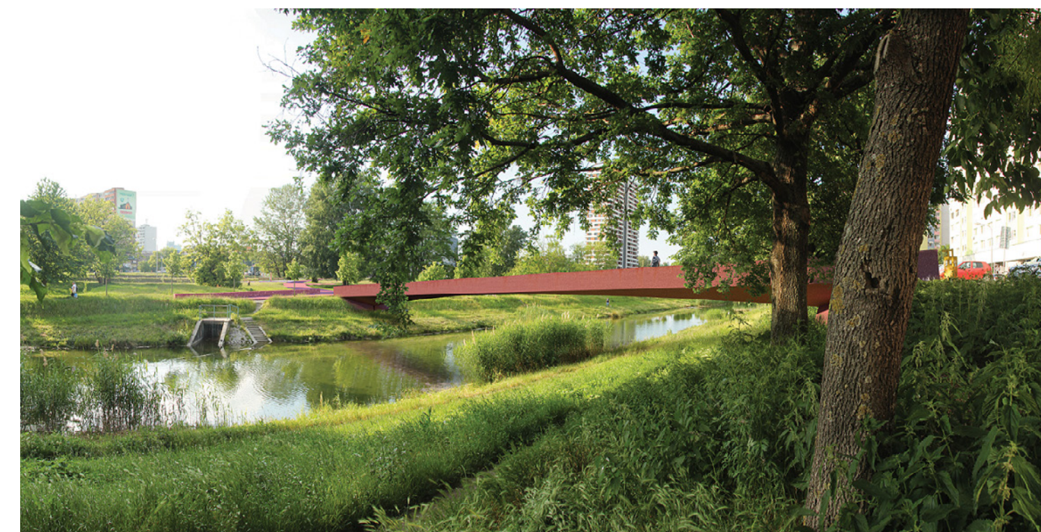
Lávky cez Chorvátske rameno
